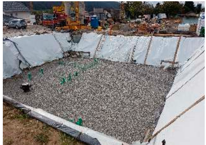
Der Untergrund wird plan mit Splitt abgezogen oder eine Magerbetonschicht eingebracht.
