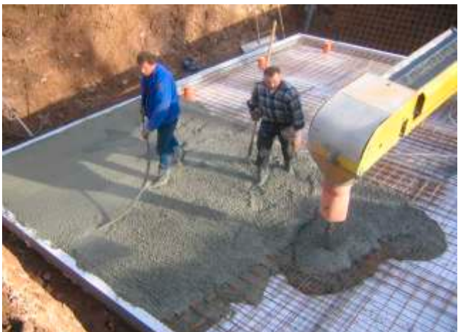
Die Bodenplatte wird mit Transportbeton betoniert.
