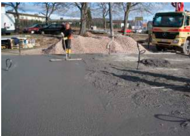
Die Bodenplatte mit den Heizungsleitungen wird dann direkt mit Transportbeton vergossen.
