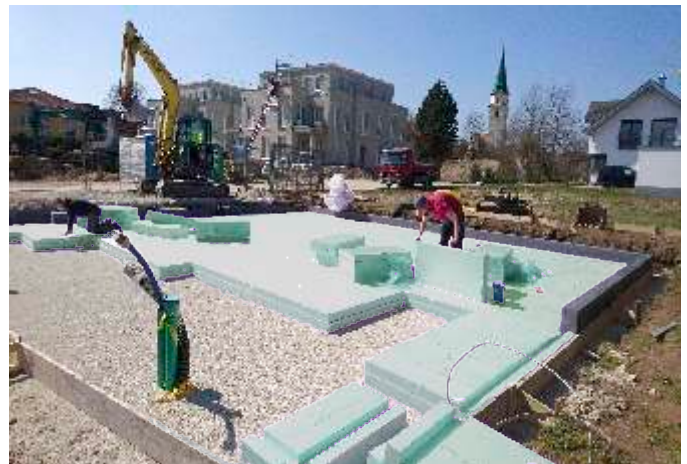
Die Fläche wird fugenlos mit den Stufenfalz-platten verlegt.
