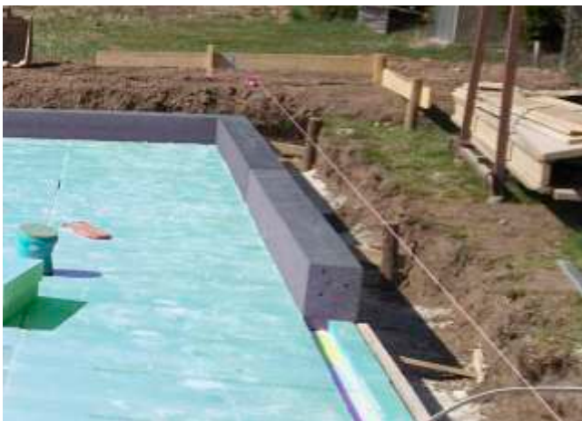
Die Platten werden nach Verlegeplan verlegt und die Aufkantung eingesteckt.
