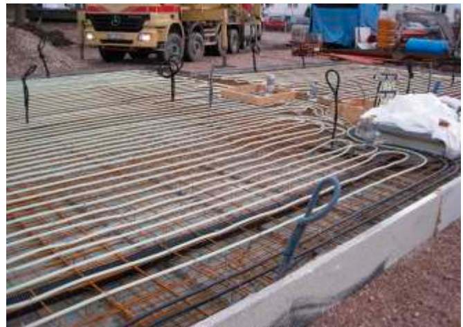
Die Leitungen werden hier direkt auf der Mattenbewehrung fixiert.
