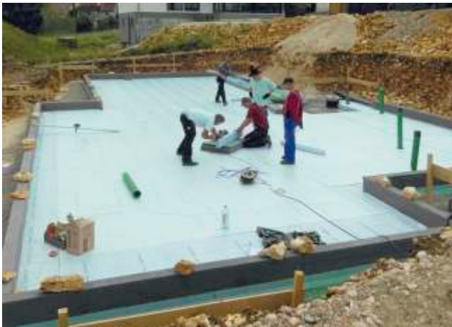
Die Entwässerungsrohre werden durch die Dämmschicht geführt.
