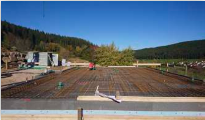
Die lastabtragende Bodenplatte ist in wenigen Stunden verlegt - kein zusätzliches Ein- und späteres Ausschalen
