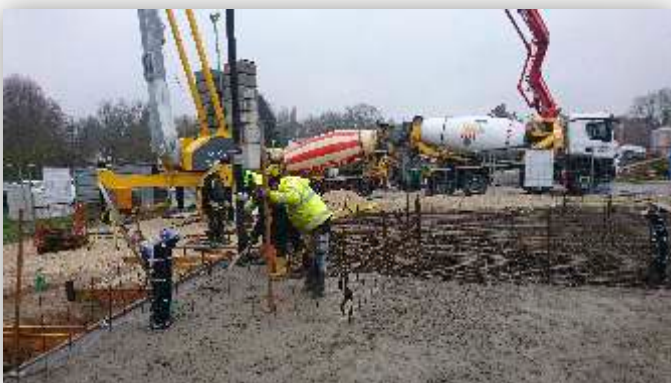
Die Bodenplatte wird mit Transportbeton betoniert
