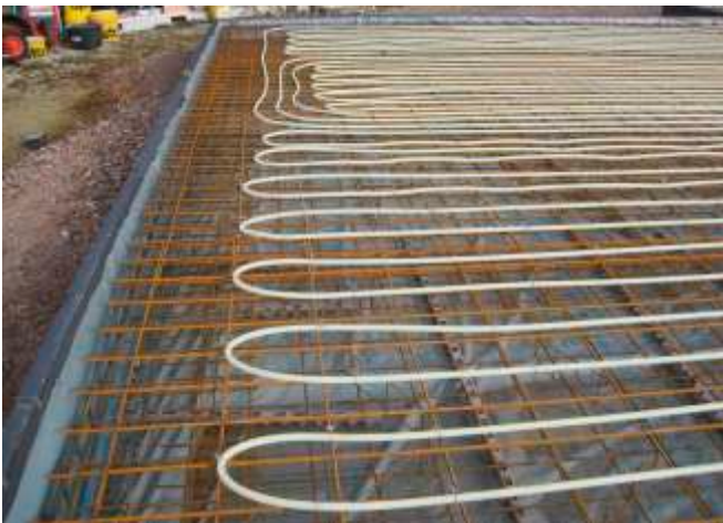
Die MAGU Bodenplattenwanne ist auch hervorragend für die Aktivierung des massiven Kernbetons geeignet
