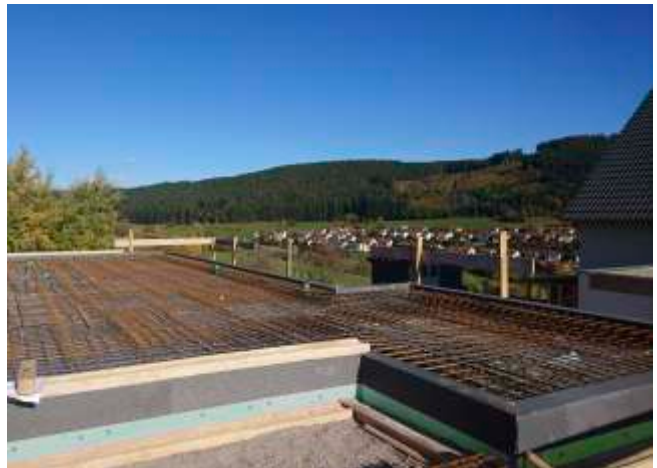
Die Baustahlarmierung wird nach den statischen Anforderungen eingebracht.
